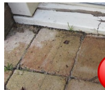
Figuur 36 Ondergrond met leklijnen
