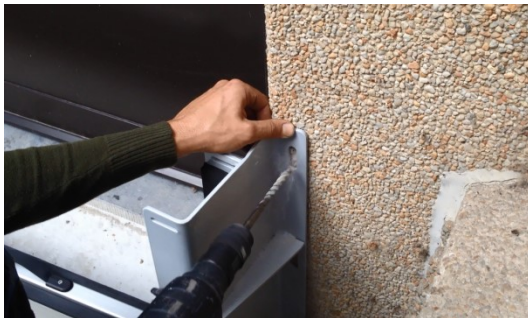
Figuur 44 Markeren van boorlocatie
