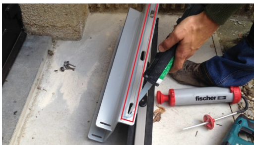
Figuur 45 Afkitten van het profiel
