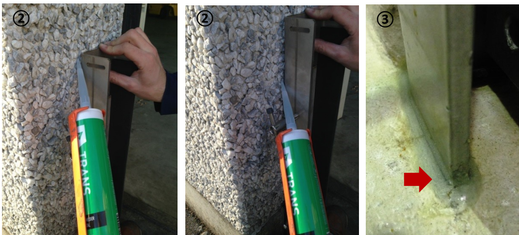
Figuur 41 Afkitten van randen en bodem
