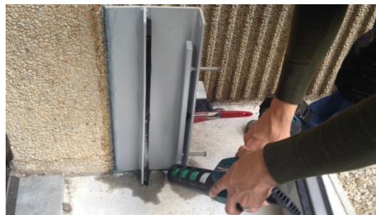
Figuur 47 Afkitten van bodemlijn
