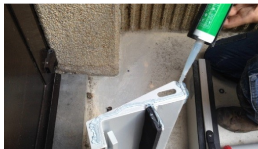
Figuur 46 Afkitten van het bodemvlak
