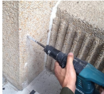
Figuur 43 Gaten boren voor ankers
