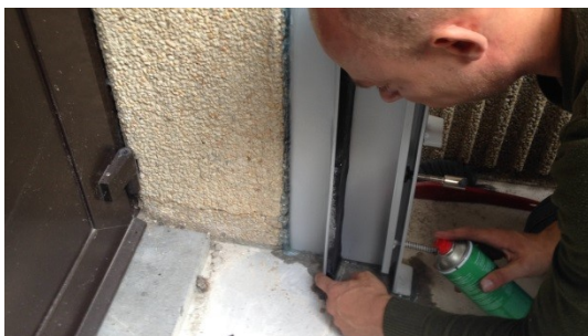
Figuur 49 Afstrijken van bodem silicone
